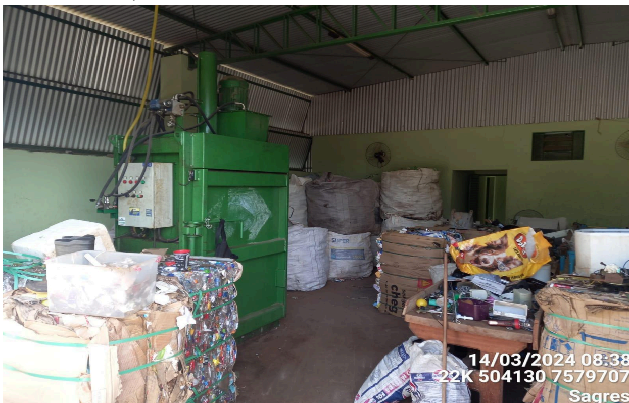
Foto 6. Interior do Galpão de triagem, com maquinários em bom estado e aspecto de organização. Fonte: GLOBAL Projetos e Meio Ambiente
