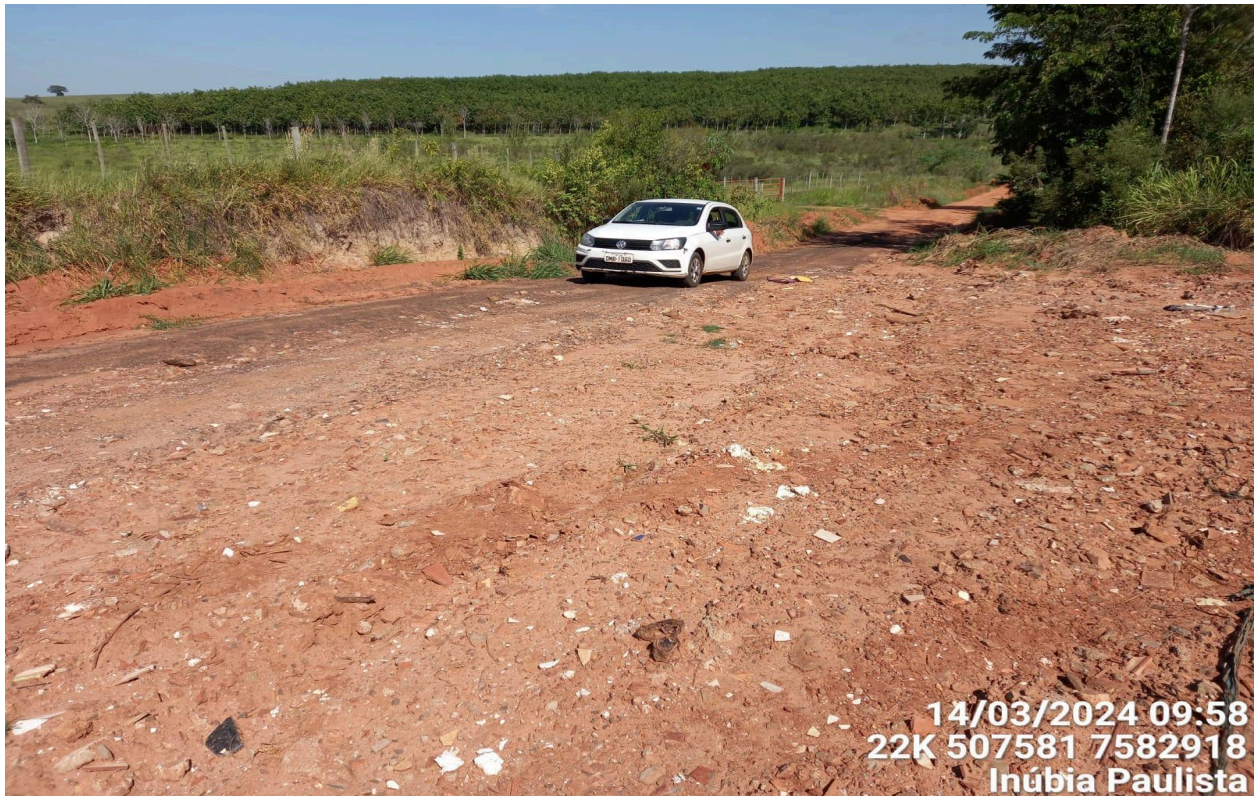
Foto 16. Estrada Rural que passou por aplicação do RCC triado visando melhorias no tráfego. Fonte: GLOBAL Projetos e Meio Ambiente
