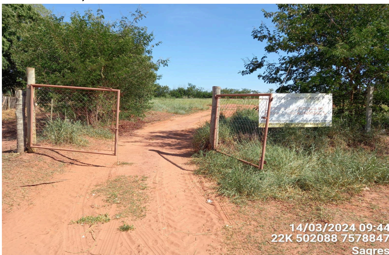
Foto 2. Porteira e placa de identificação no aterro em valas. Fonte: GLOBAL Projetos e Meio Ambiente
