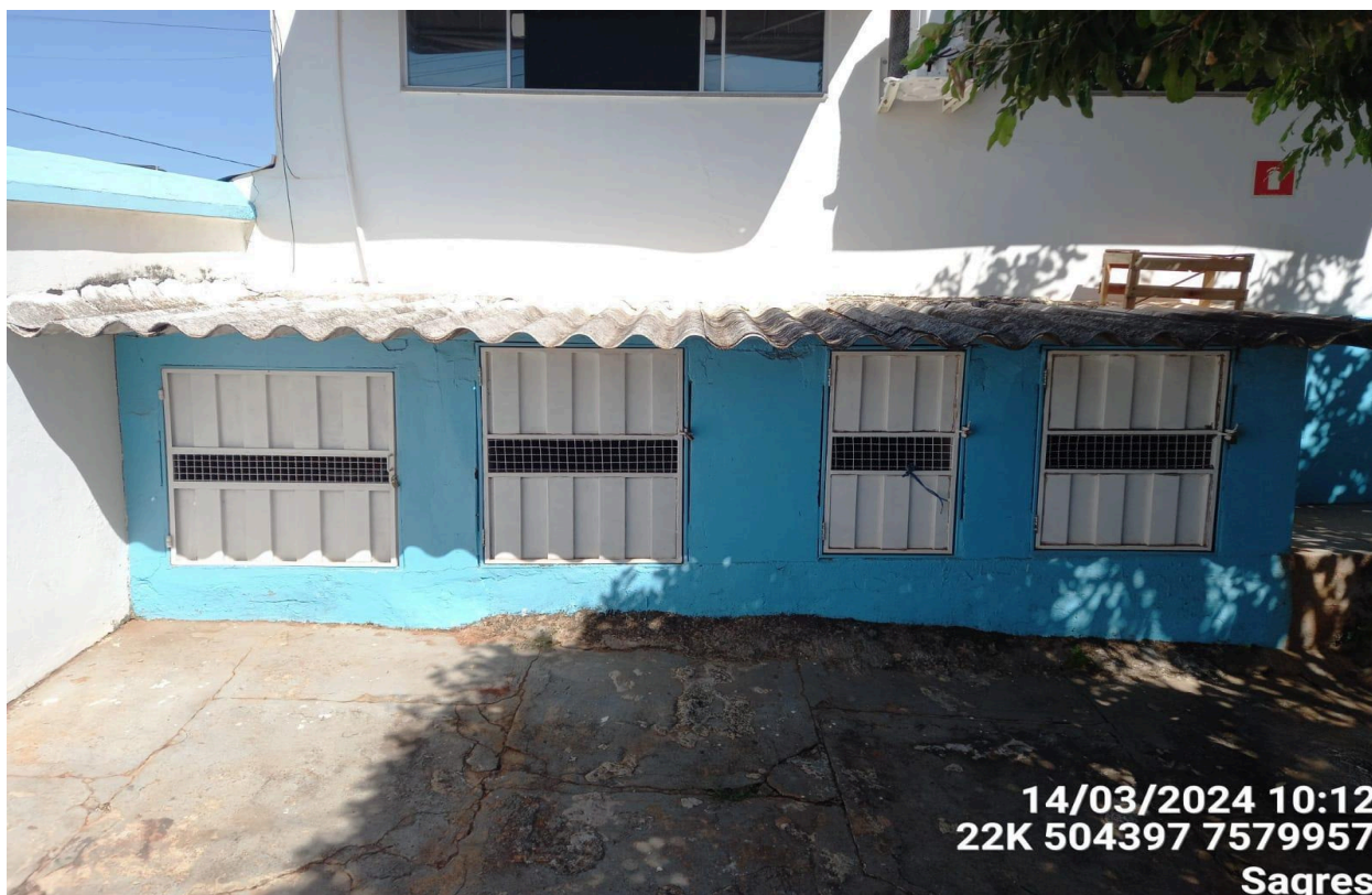
Foto 18. Estrutura para disposição temporária dos RSS gerados pelos empreendimentos públicos municipais.
