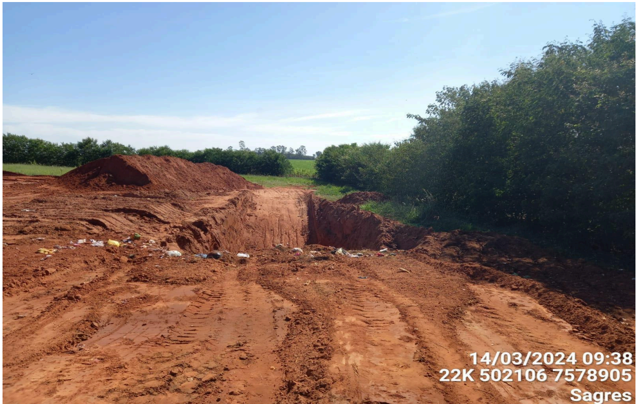
Foto 3. Vala aberta para aterramento de resíduos e cinturão verde no aterro em valas. Fonte: GLOBAL Projetos e Meio Ambiente
